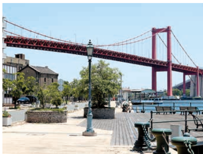
若戸大橋と若松南海岸通り
