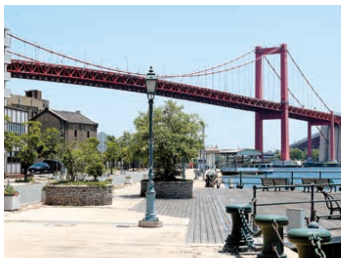
若戸大橋と若松南海岸通り
